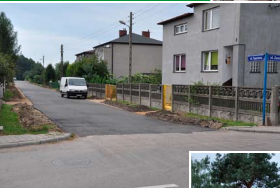
Położona została nawierzchnia na ul. Sportowej w Poraju
