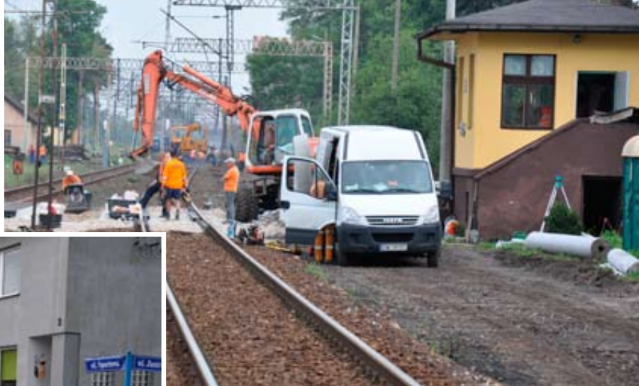
Trwa przebudowa przejazdu w Poraju
