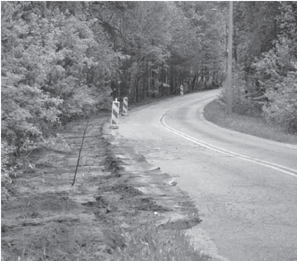
Budowa chodnika - ul. Letniskowa w Żarkach Letnisku
