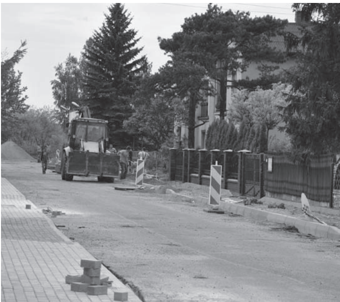
Budowa nawierzchni w ciągu ul. Wesola i Leśna w Poraju
