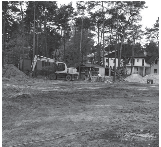
Budowa przedszkola w Żarkach Letnisku rozpoczęta
