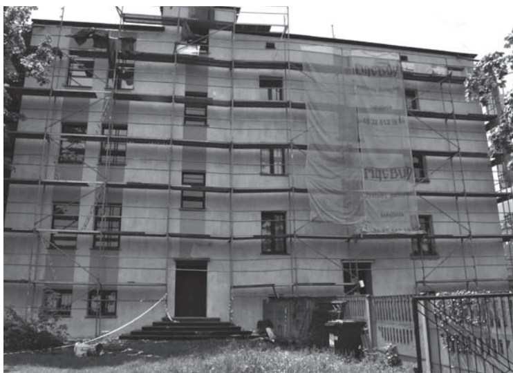
Termomodernizacja Szkoły Podstawowej w Poraju
