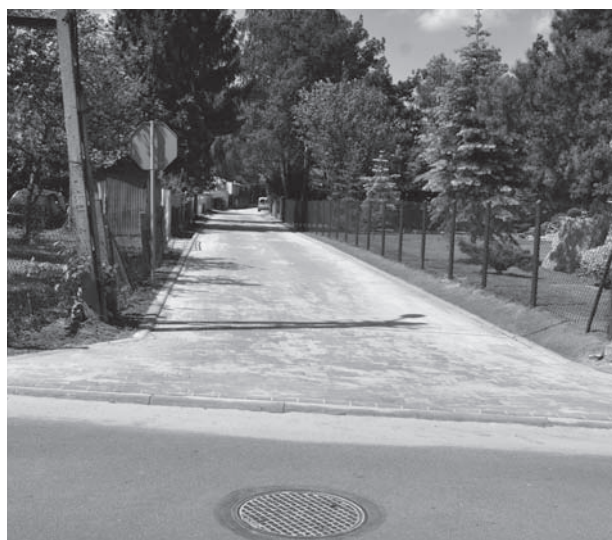
Remont nawierzchni ul. Kochanowskiego
