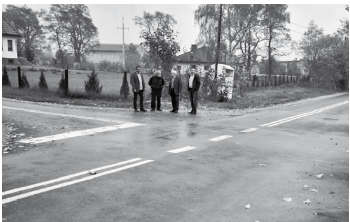
Efekt prac na ul. Partyzantów jest widoczny
