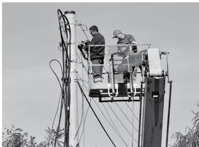
Lampy zmieniane są na nowe i energooszczędne, z rtęciowych na sodowe, oszczędniejsze o ok. 30%.
