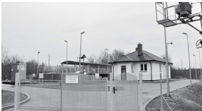
Otwarcie oczyszczalni ścieków dla Jastrzębia
