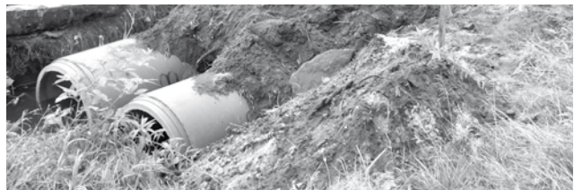
W 2014 roku kontynuowane były prace przy odwodnieniu gminy
