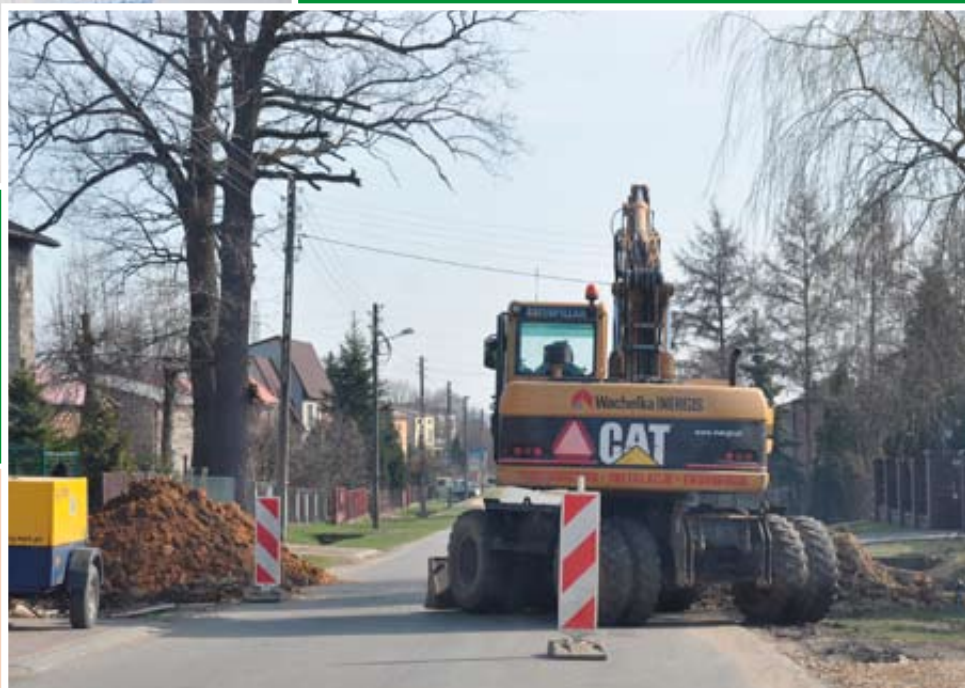
Rozstrzygnięty został przetarg na II etap budowy kanalizacji w Jastrzębiu
