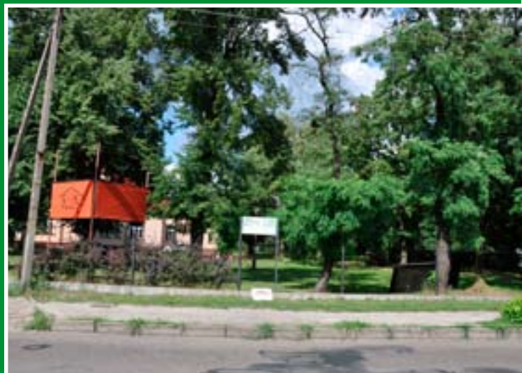
Zdemontowany został płot przed budynkiem GOK w Poraju.
