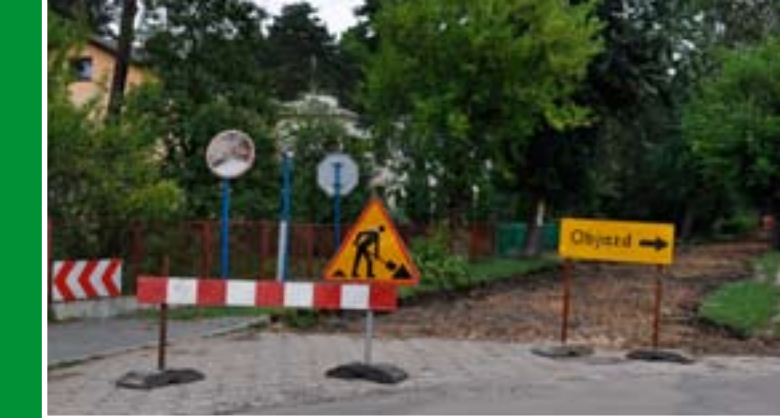
Trwa przebudowa drogi gminnej ul. hr. Raczyńskiej w Żarkach Letnisku.
