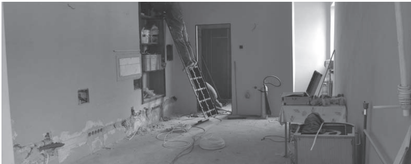
Modernizacja sali widowiskowo - kinowej „Bajka” w Poraju
