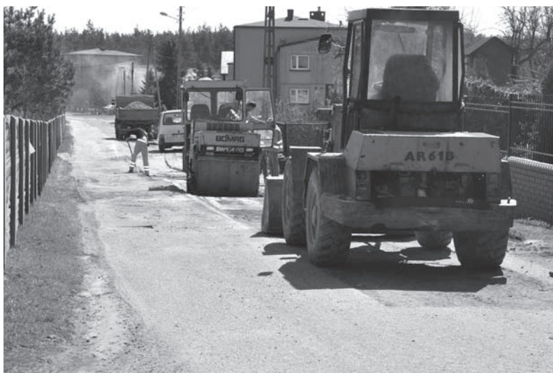
II etap budowy kanalizacji w Jastrzębiu
