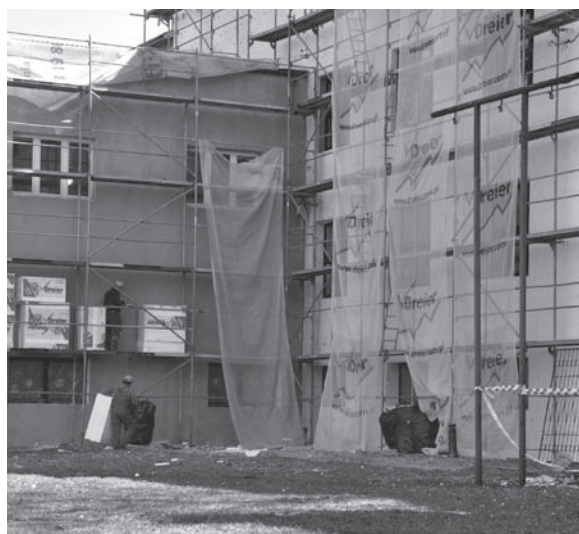
Termomodernizacja Szkoły Podstawowej w Poraju
