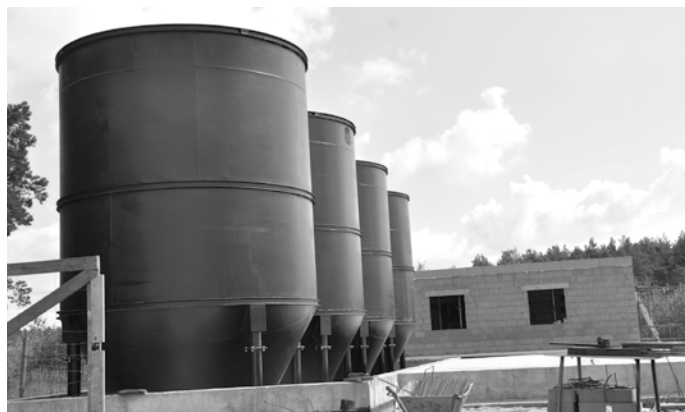
Trwają intensywne prace przy budowie oczyszczalni ścieków
