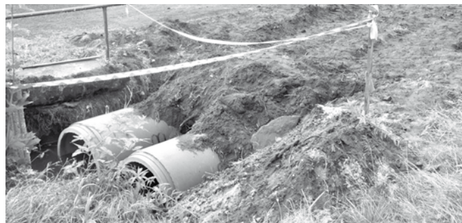
W 2013 roku kontynuowane były prace przy odwodnieniu gminy
